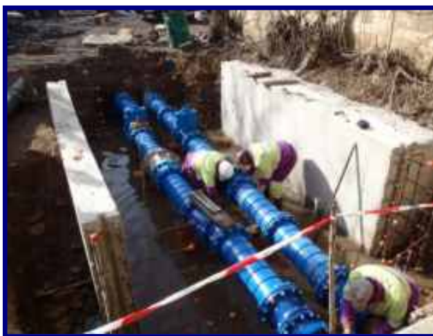
Mantenimiento de conducciones hidráulicas
