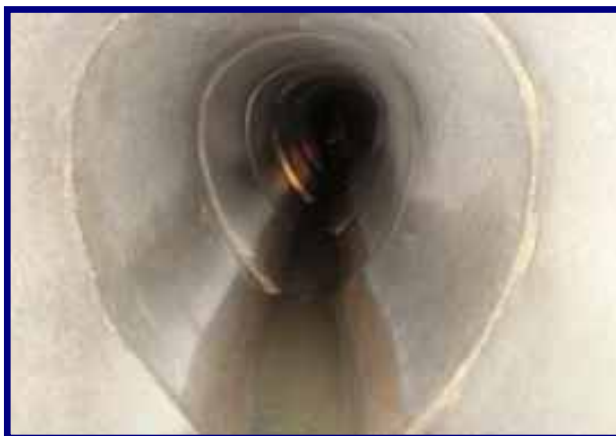
Inspección de saneamiento por CCTV
