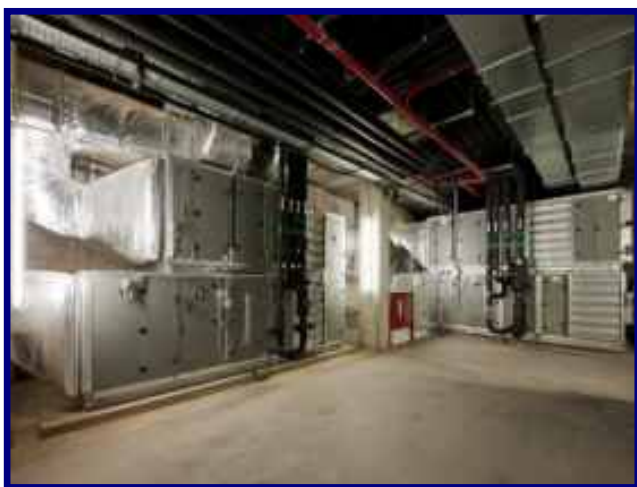
Mantenimiento de edificios e instalaciones
