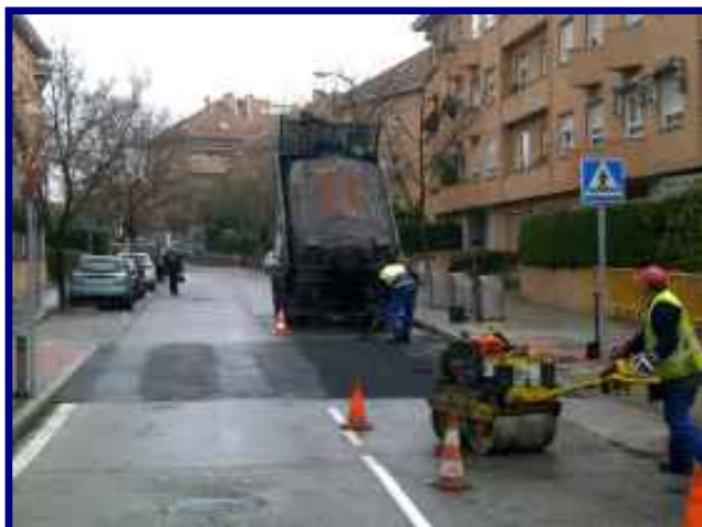
Conservación de pavimentos
