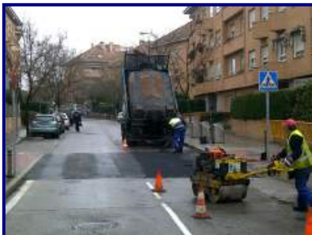
Conservación de pavimentos
