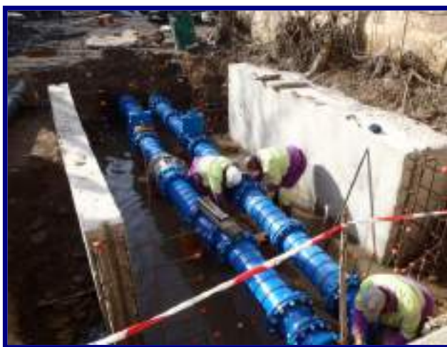
Mantenimiento de conducciones hidráulicas
