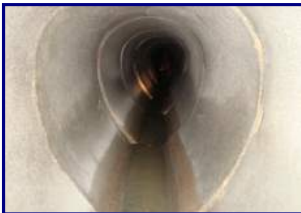
Inspección de saneamiento por CCTV
