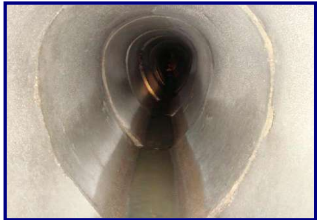
Inspección de alcantarillado por CCTV
