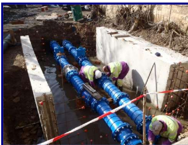
Mantenimiento de conducciones hidráulicas
