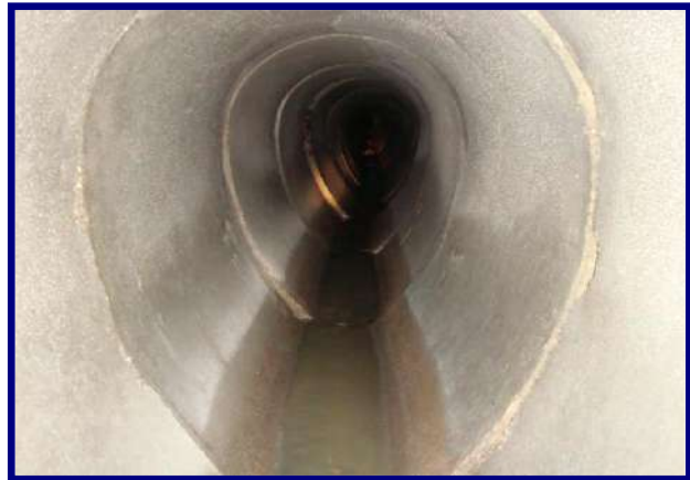
Inspección de alcantarillado por CCTV
