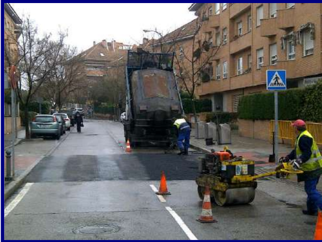
Conservación de pavimentos
