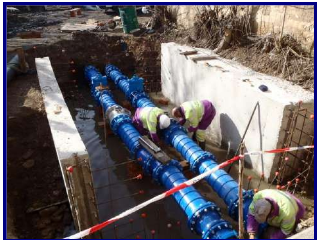
Mantenimiento de conducciones hidráulicas
