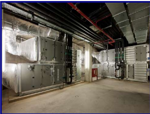
Mantenimiento de edificios e instalaciones
